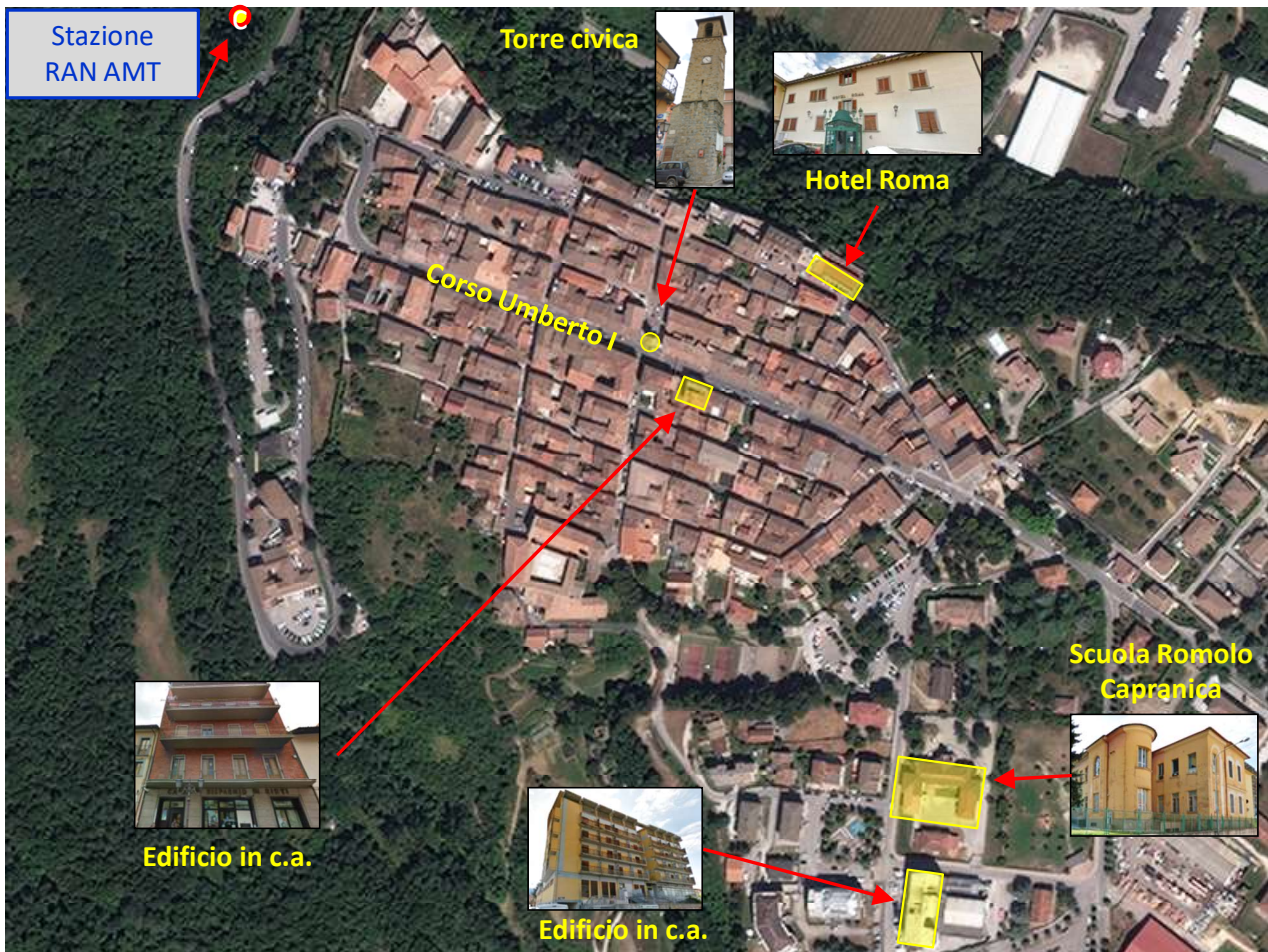
Figura 7: Mappa del comune di Amatrice (adattato da https://www.geospatialworld.net/esi-usqs-data-help-understand-italy-earthquake-damage/ ) con localizzazione di alcuni edifici di interesse e posizione della stazione AMT
