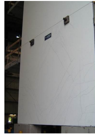
Figure 11. Marked crack pattern on one bottom modulus of wall after the tests / Profilo di fessurazione evidenziato a pennarello sul modulo inferiore di un muro dopo le prove.
