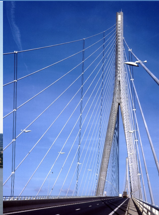
Pont de Normandie (1995) campata centrale 856 m (record fino al 1998)
